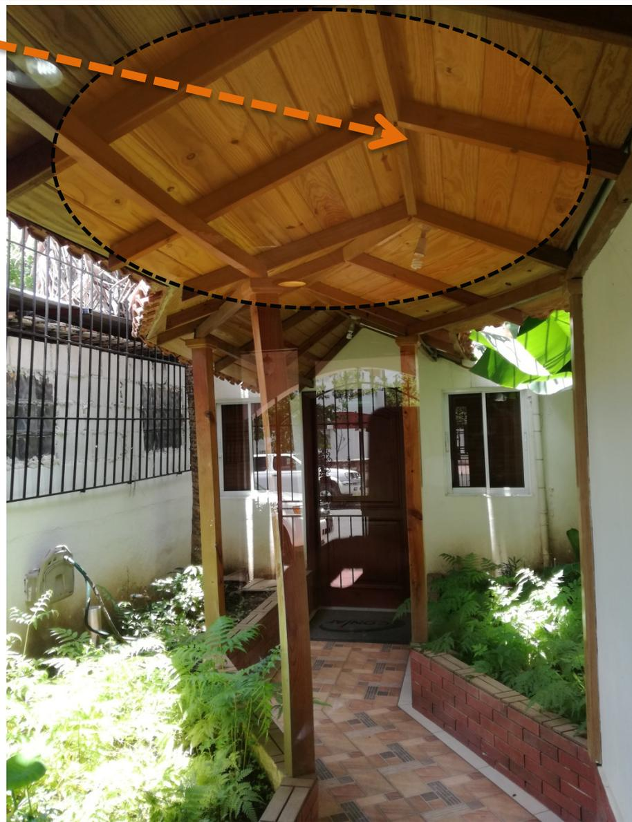
SE PROPONE TECHO INCLINADO DE UNA SOLA AGUA, A SER PROVISTO DE UNA CANALETA QUE VIERTA LIBREMENTE LAS AGUAS COLECTADAS HACIA EL EXTERIOR DEL INMUEBLE.
