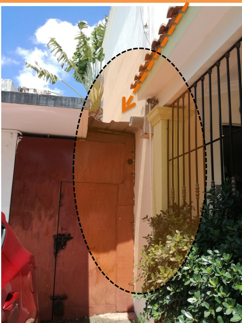
REFERIRSE AL DISEÑO ARQUITECTÓNICO PARA VER EL DESTINO FINAL DEL TERMINAL DE LA CANALETA QUE DEBE SER PROVISTO DE UNA TUBERÍA QUE DESAGUE DE LA MANERA MÁS ESTÉTICA POSIBLE EN ESTE LINDERO LATERAL MOSTRADO EN LA FOTO.
